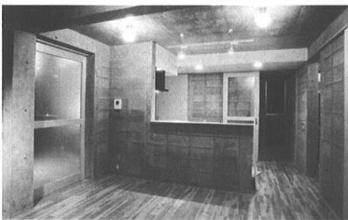
とブロック内部の湿気を考慮してCB表しとした。また外壁には熱効率の良い外断熱工法の採用を念頭に置いた。外断熱工法はRC造で何棟か経験があり、木製の胴縁を取り付けて間に断熱材（現場発泡ウレタン）を入れて通気を取りながら外壁を張る方式を採用した。庇も極力設けて外壁を保護した。またCB造の開口部はこれまで大きくは取れないと思っていたが、ブロック積みによる腰壁や臥梁下のブロック積み無くし全ての開口に床から臥梁下までの住宅用サッシを使用した。また最大の課題である建築コストだが、木造住宅の建設費に対抗できる水準にかなり近づけることができた。
